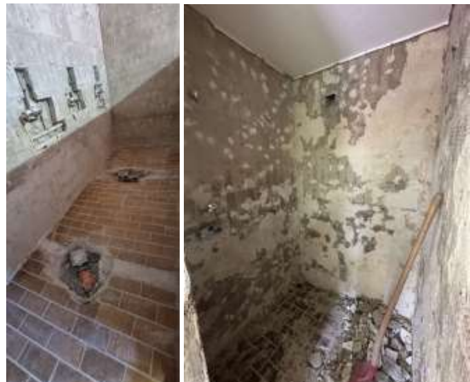
Aktuelle Fotos der Renovierung
